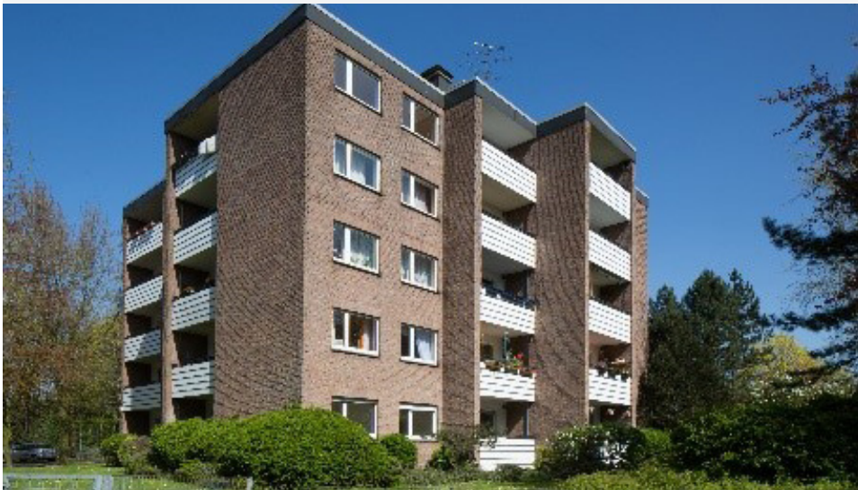
Gebäudebestand in Wesel Scherpersfeld [ICM]
