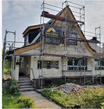
Einfamilienhaus in Sanierung (ICM)
