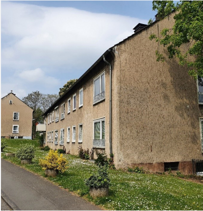
Unsanierte Mehrfamilienhäuser (ICM)
