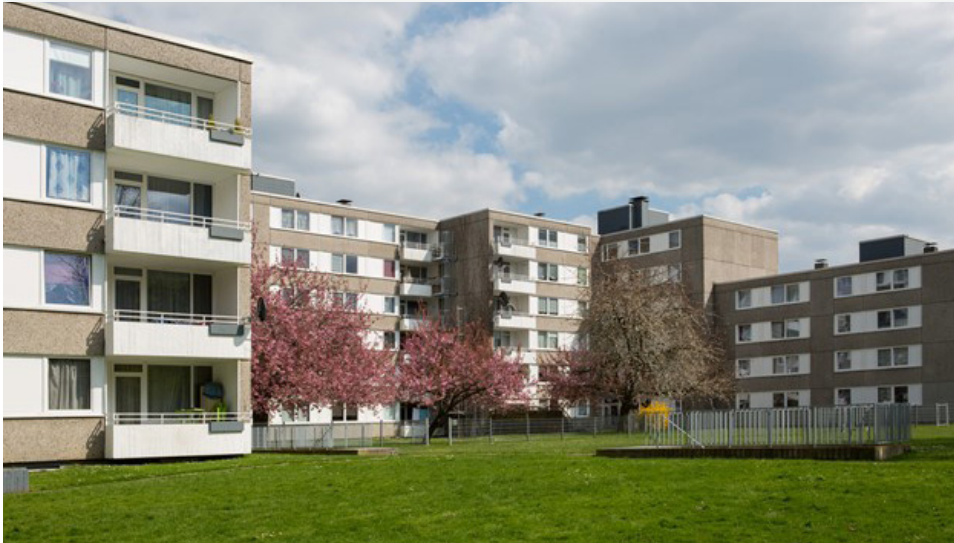
Gebäudebestand in Dortmund Westerfilde-Bodelschwingh [ICM]
