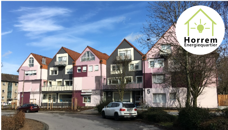
Fassadengestaltung im Quartier (ICM), Logo Energiequartier Horrem (ICM)
