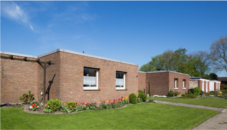
Gebäudebestand in Gladbeck Rentford-Nord [ICM]
