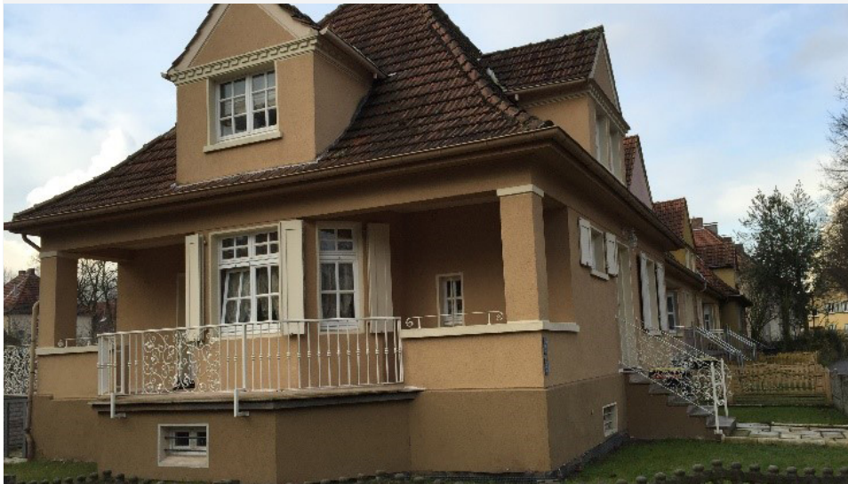
Gebäudebestand im Stadtquartier Lohberg [ICM]
