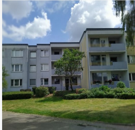
Geschosswohnungsbau im Quartier (ICM)
