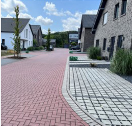
Neubau im Quartier (ICM)
