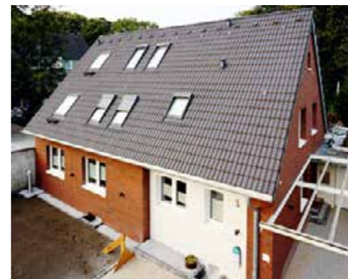
Zu einem Plus-Energiehaus umgewandelt wurde unter anderem mit Steinwolle-Dämmstoffen von ROCKWOOL ein Bottroper Einfamilienhaus aus dem Jahr 1962
