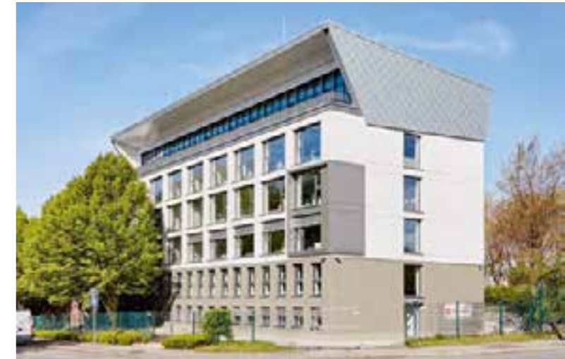
Sanieren statt neu bauen: Die DEUTSCHE ROCKWOOL versteht ihr eigenes Bürogebäude aus dem Baujahr 1974 als Zukunftsmodell für viele Unternehmen. Nach der Sanierung benötigt es nun 80 % weniger Energie.
