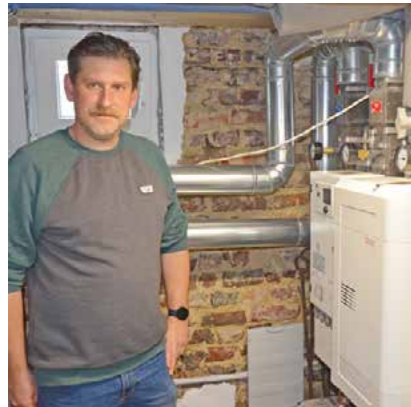
Wichtiger Aspekt der Sanierung: die Modernisierung der Haustechnik. Foto: ICM
