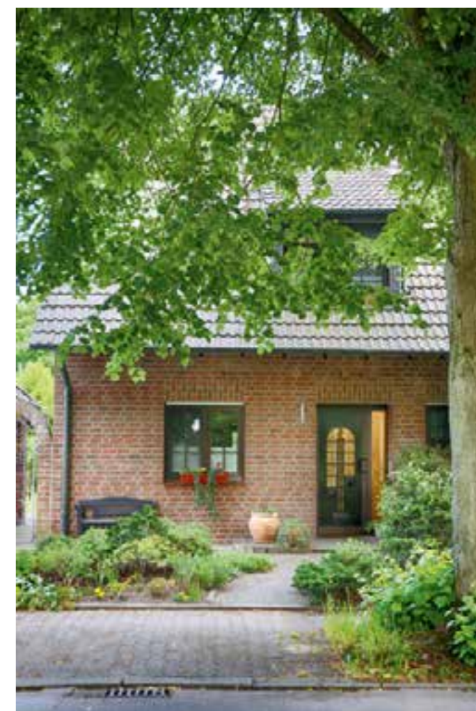
Von der Straße aus sind die Solarmodule der Photovoltaikanlage auf dem Dach nicht einsehbar. Fotos: ICM
